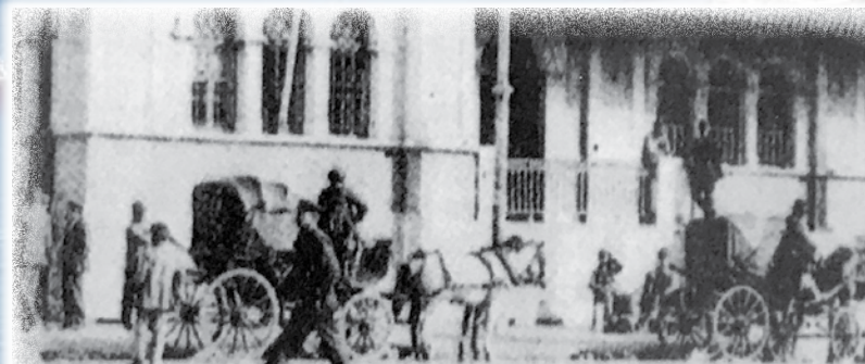
Ο πρώτος σταθμός του ΣΑΠ
