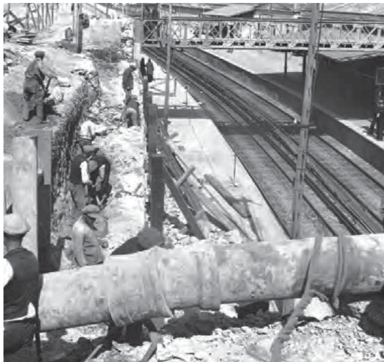
Συνάντηση του αγωγού με σιδηροδρομική γραμμή.
