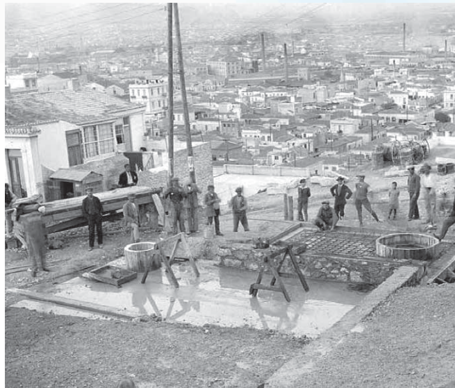
1936, Κατασκευή δεξαμενής εντός πόλεως
