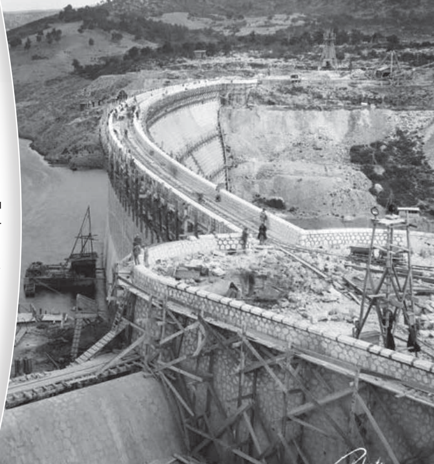
1929, Στάδιο κατασκευής Φράγματος Μαραθώνα.
