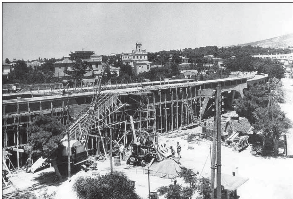
1956. Κατασκευή του σταθμού Αμαρουσίου.
