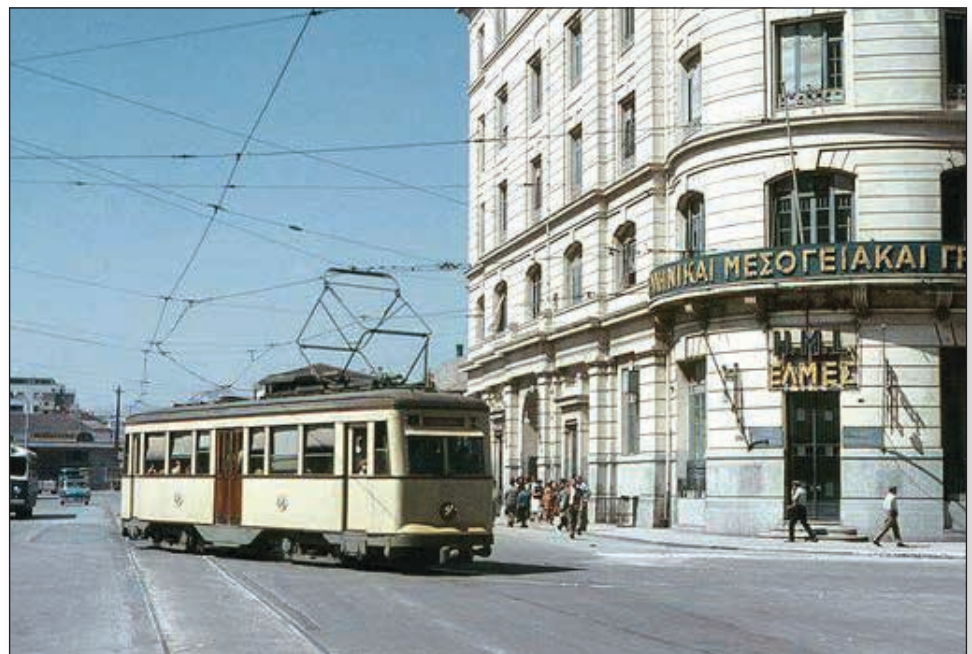
1959. Σταθμός ΕΗΣ ΗΣΑΠ Πεφραιά.
