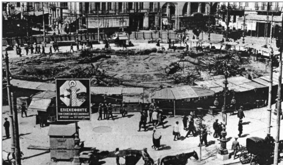
Η πλατεία Ομονοίας, κατά την έναρξη των εργασιών εκσκαφής για την κατασκευή του υπογείου σταθμού των Ε.Η.Σ., τον Σεπτέμβριο του 1927
