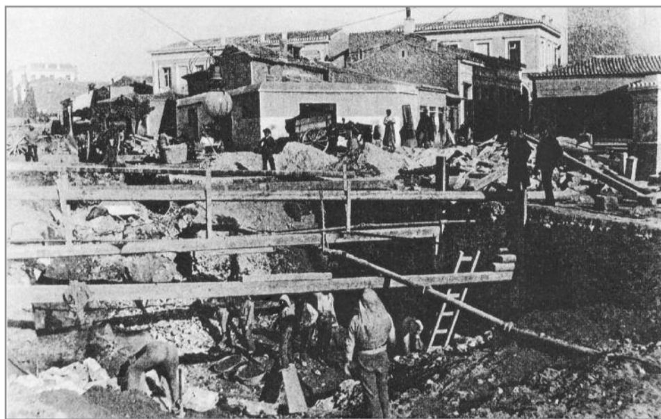
Από τα έργα διανοίξεως της σήραγγας Θησείου - πλατεία Ομοιοίας στο τμήμα Μοναστηρακίου - πλατείας Ομοιοίας 1889
