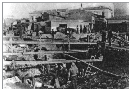
Από τα έργα διανοίξεως της σήραγγας Θησείου - πλατείας Ομονοίας, στο τμήμα Μοναστηρακίου - Πλατεία Ομονοίας, 1889.
