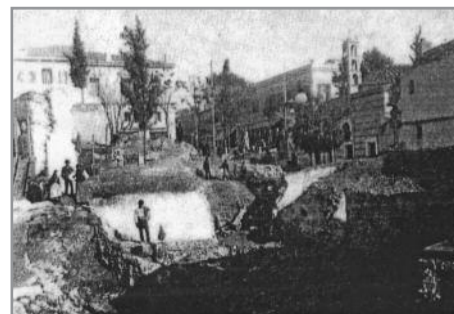
Από τα έργα διανοίξεως της σήραγγας Θησείου - πλατείας Ομονοίας, στο ύψος της οδού Αδριανού, 1889. Η εκκλησία που διακρίνεται είναι του Αγ. Φιλίππου
