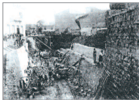
Από τα έργα προεκτάσεως της σιδηροδρομικής γραμμής από το Θησείο ως την Πλατεία Ομονοίας, 1889.
